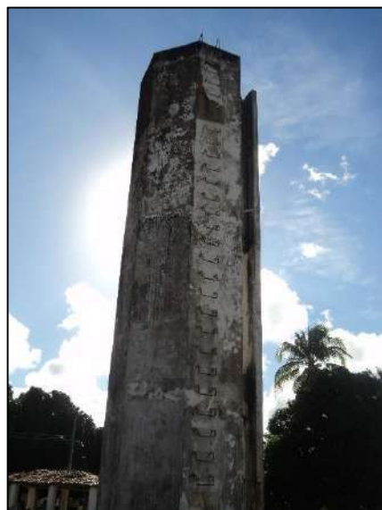
(c) Detalhe escada de acesso
