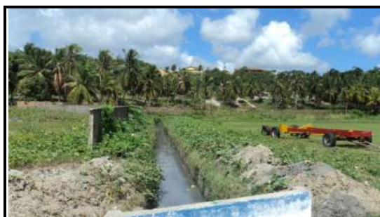
(e) Canal que deságua no reservatório de detenção
