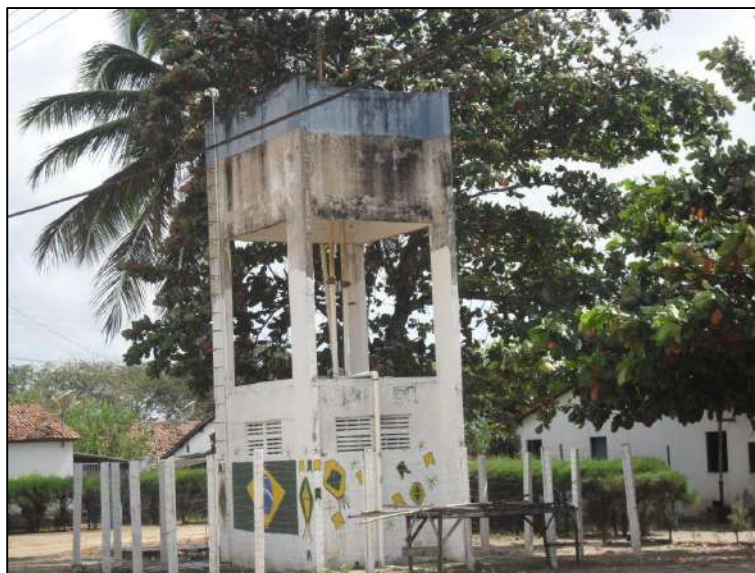
Figura 3. 24 – Vista do reservatório elevado da Vila da Usina. Fonte: CAERN (2010).
