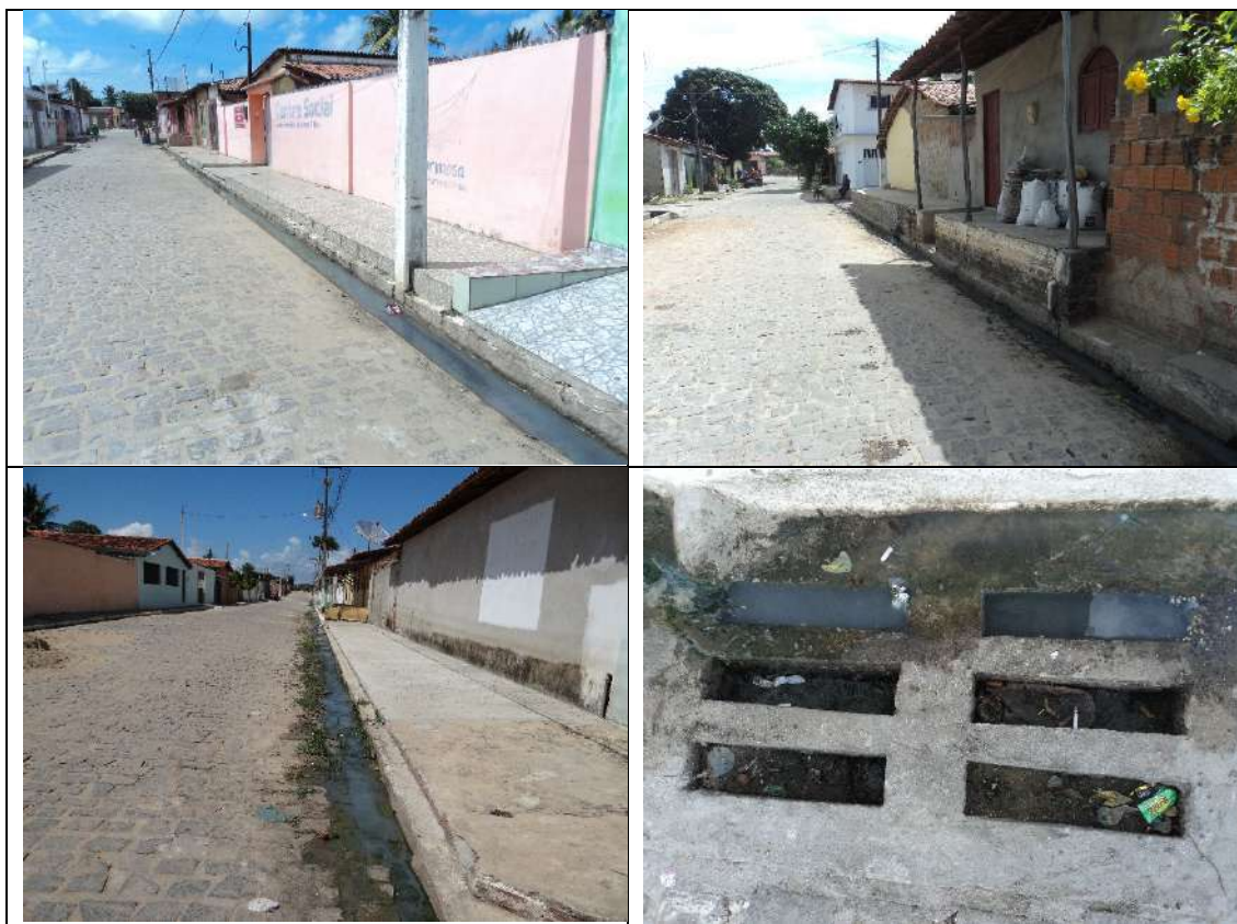
Figura 3. 2 – Águas servidas dispostas a céu aberto nos dispositivos de drenagem na sede do município de Baía Formosa. (continua)
