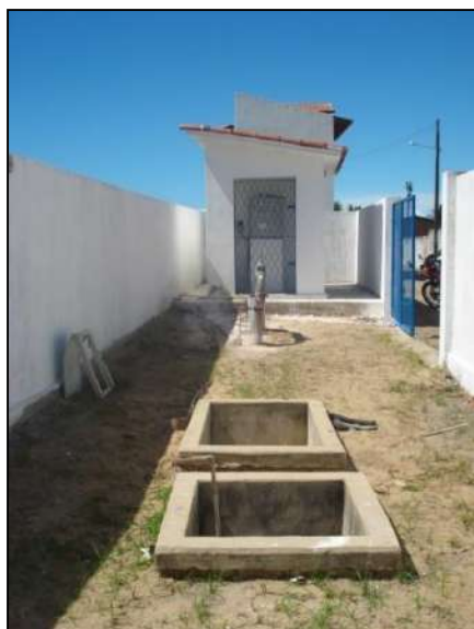
(a) Área onde está instalado o poço P2
