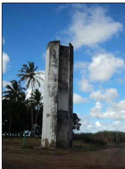
(a) Vista do reservatório
