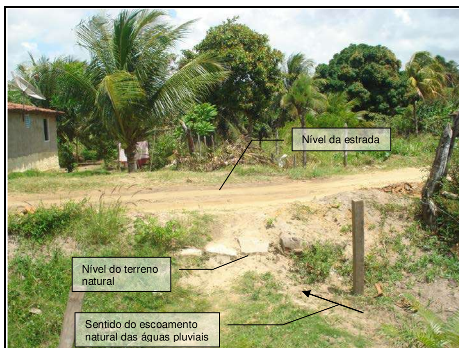
(c) Vista do talude da estrada
