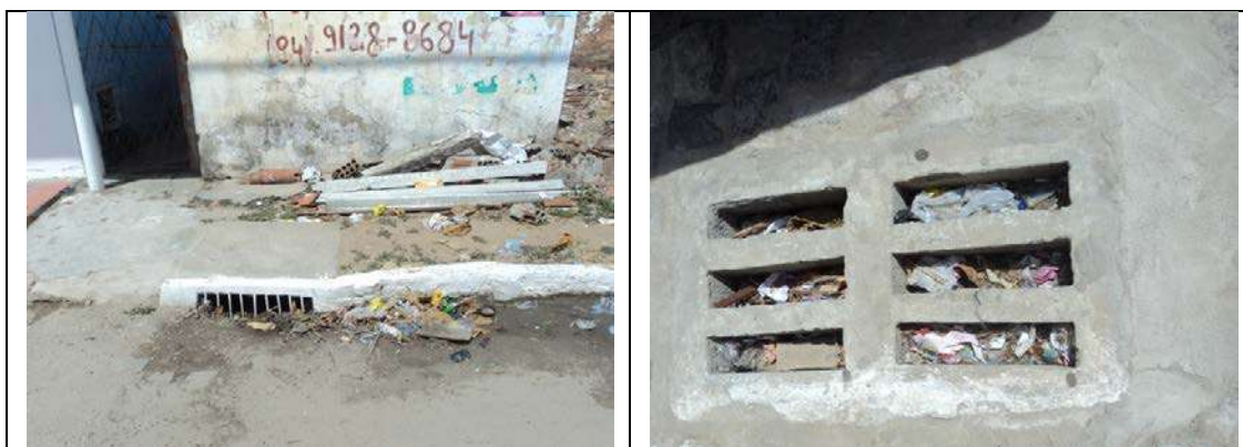
Figura 4. 6 – Vistas de resíduos sólidos em dispositivos de drenagem na área urbana do município de Baía Formosa.
