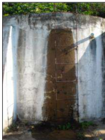
(b) Escada de acesso
