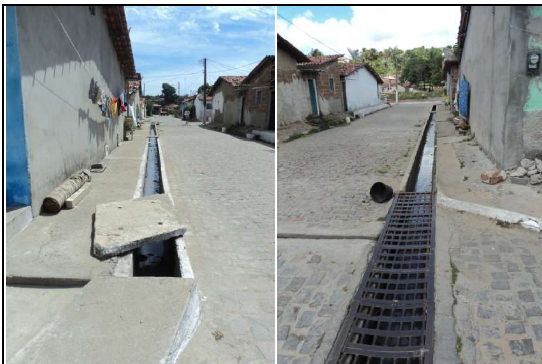
Figura 3. 9 – Disposição de águas residuárias no sistema de drenagem de águas pluviais.
