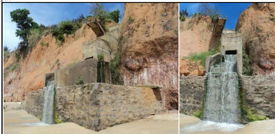
(g) Dissipador de energia
