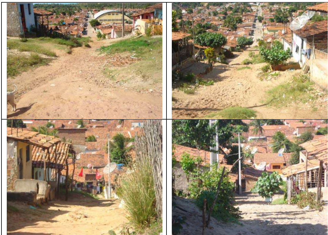
Figura 4. 11 – Acesso aos domicílios do Morro do Senhor Pela.
