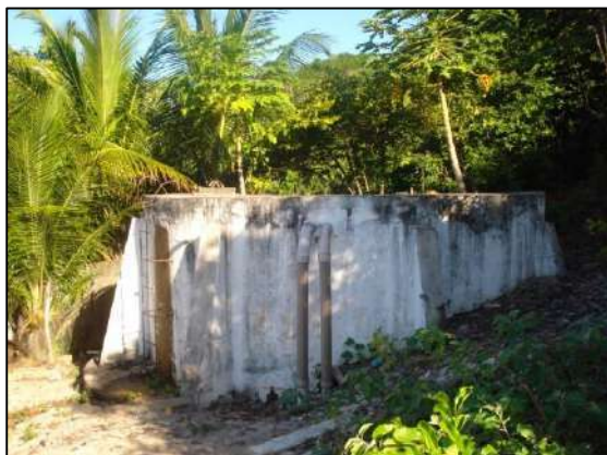
(a) Vista do reservatório
