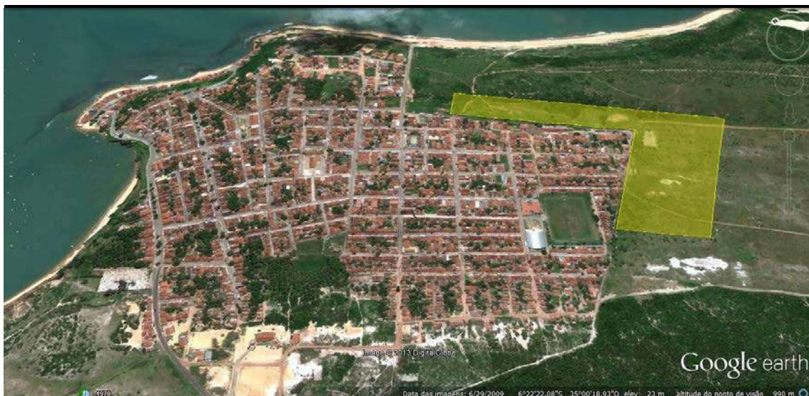
Figura 3. 8 – Loteamento particular que se encontra em implantação nas adjacências da cidade de Baía Formosa.
