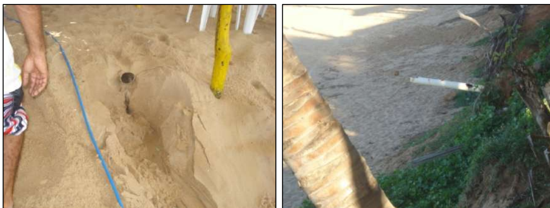
Figura 3. 5 – Pontos de lançamento de águas servidas na beira-mar em Baía Formosa. Fonte: CAERN (2010).
