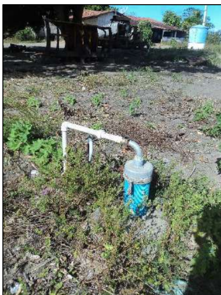
(a) Poço PS 1310
