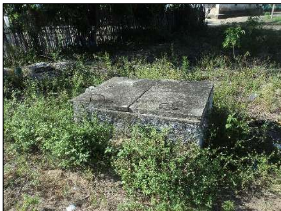
(a) Vista estrutura de proteção do poço
