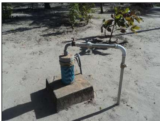
(a) Poço PS 1301
