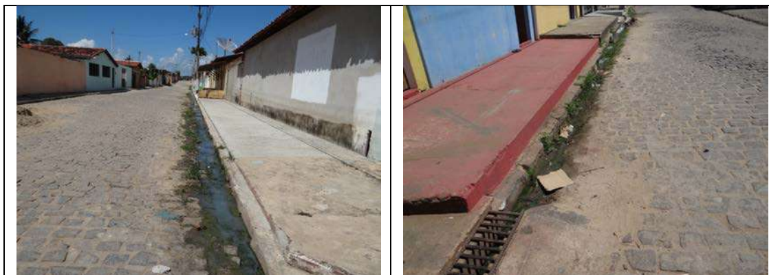
Figura 4. 26 – Escoamento de águas cinza nos dispositivos de drenagem da sede municipal.
