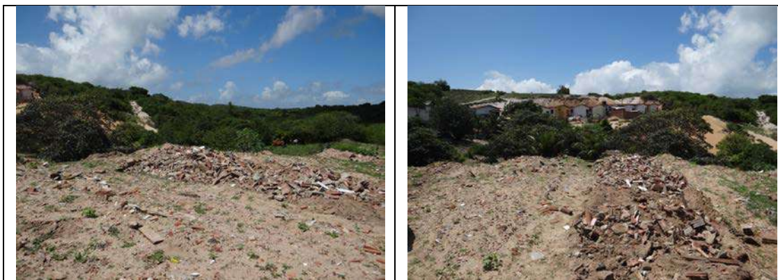
Figura 4.27 – Local de despejo dos RCD na sede do município de Baía Formosa.
